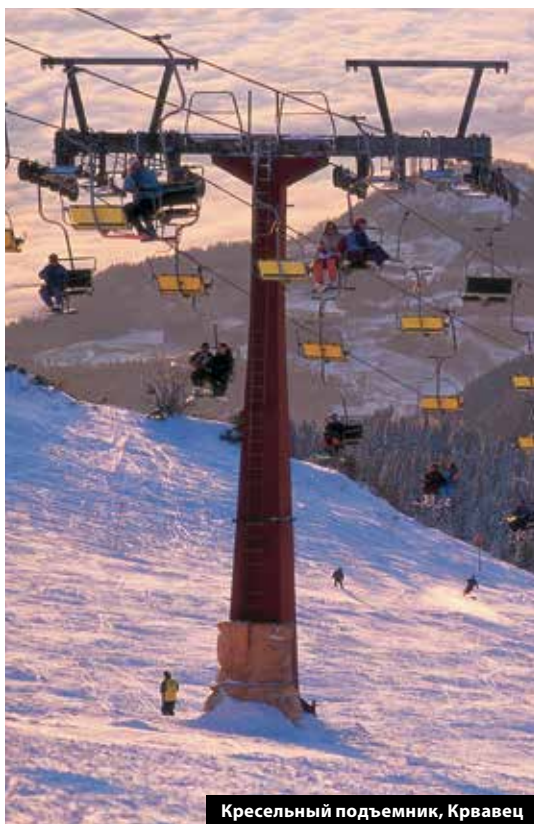
Кресельный подъемник, Крвавец
